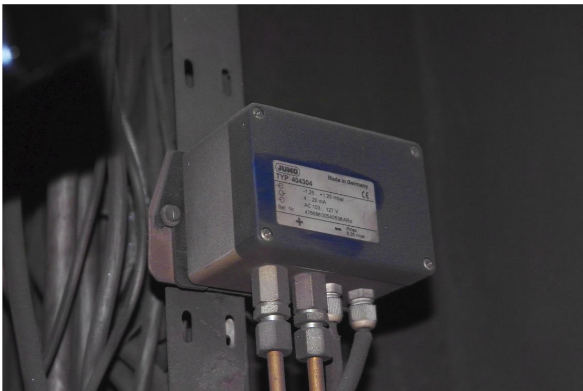
Slika 4.15. Tipalo pritiska žarilne peči
