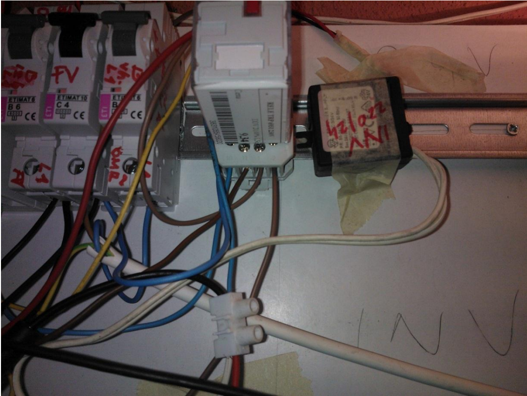
Slika 3.17 Vezava izhodov krmilnika na rele
