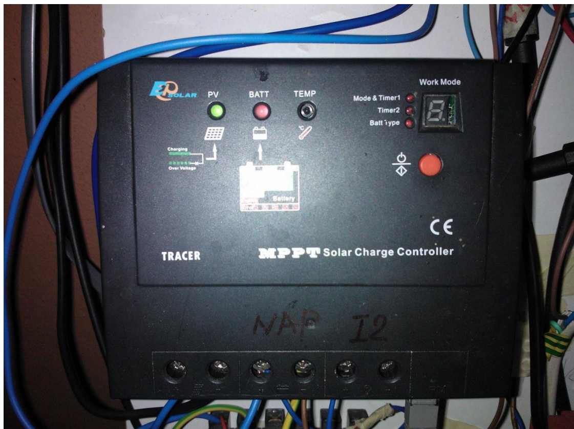
Slika 2.27 Priklučitev gradnikov na regulator MPPT
